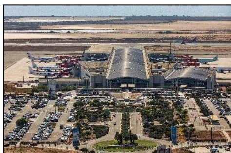
→ Διεθνής Αερολιμένας Λάρνακας
